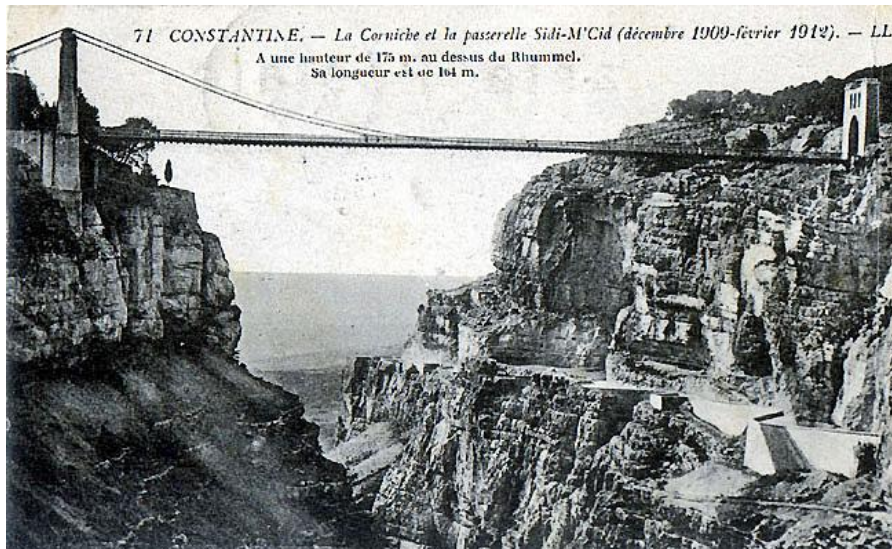
La passerelle Sidi M'Sid
